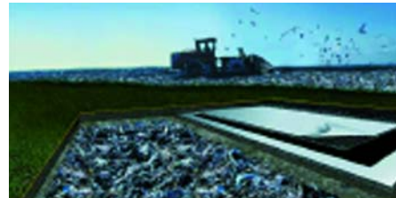
Es. 2 drenaggio biogas e acqua meteorica in capping di discarica
