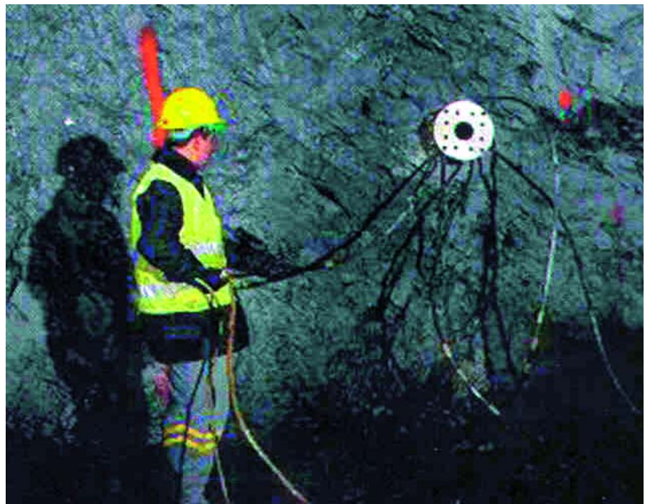
Risanamento con PETRAPUR di opere storiche e monumentali
